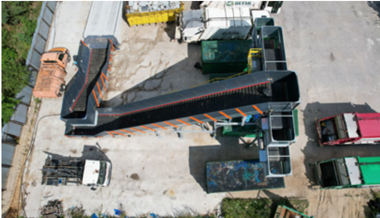
Kompletna stacja nie zajmuje dużo miejsca, dzięki czemu łatwo ją zmieścić nawet na niewielkim terenie. Przeladunek odpadów odbywa się bardzo sprawnie i nie dochodzi do ich rozprzaskania.
