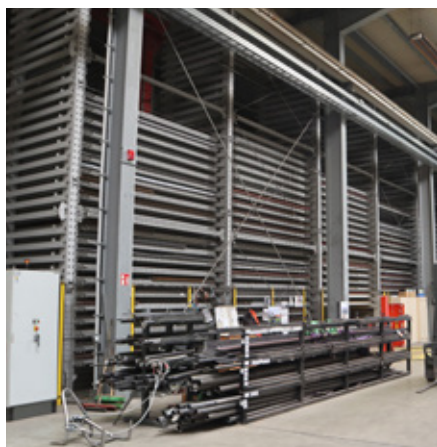
Ukończony w 2013 r. automatyczny magazyn ma ponad 200 stanowisk na arkusze blachy stalowej o wymiarach 4x2 m.
