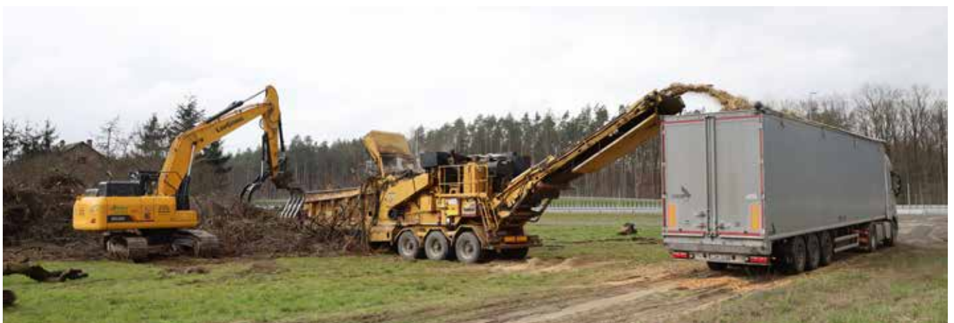
To idealne ustawienie sprzętu, w którym przetwarzany materiał od razu jest załadowywany na naczepę. Niestety często uniemożliwia je ograniczona przestrzeń lub brak odpowiedniego dojazdu.
