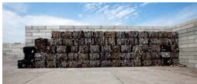
Ściana BETBLOK SYSTEM jest wytrzymała i stabilna, dzięki czemu może być odpowiednim oparciem dla najcięższych sprasowanych surowców wtórnych.
