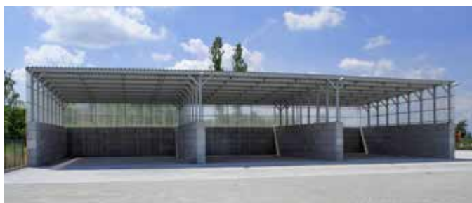
Bloki BETBLOK SYSTEM nie są zbrojone, więc łatwo do nich montować różne elementy, w tym zadaszenie, które typowe boksy przekształca w wielofunkcyjną wiatę.
