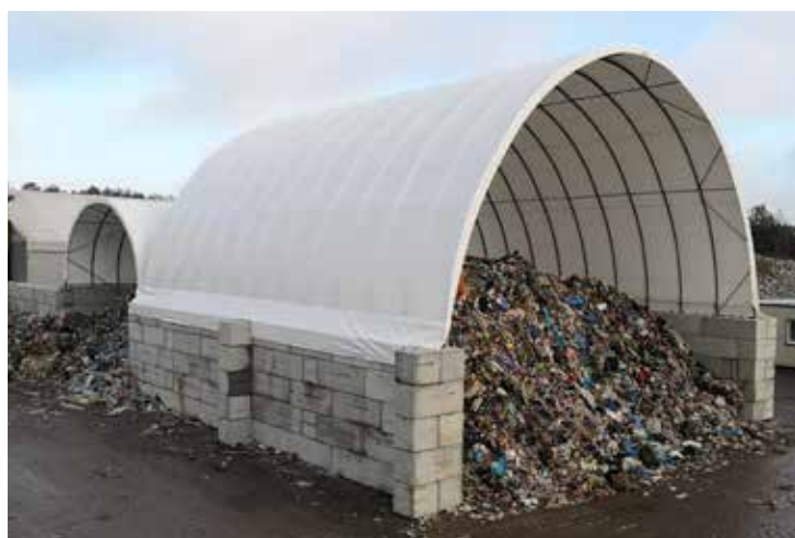
Hale tunelowe SHELTERALL stanowią znakomitą alternatywę dla tradycyjnych form magazynowania. Mają modułową budowę i w każdej chwili można zmienić miejsce ich posadowienia. Prezentowana hala ma szerokość 12 m, długość 15 m i wysokość 6,75 m (+3 m wysokość bloków betonowych).
